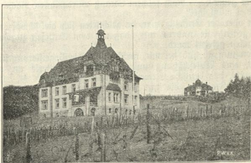
Erholungshaus der badischen Anilin- und Sodafabrik. (Sintergrund städt. Kurhaus).
