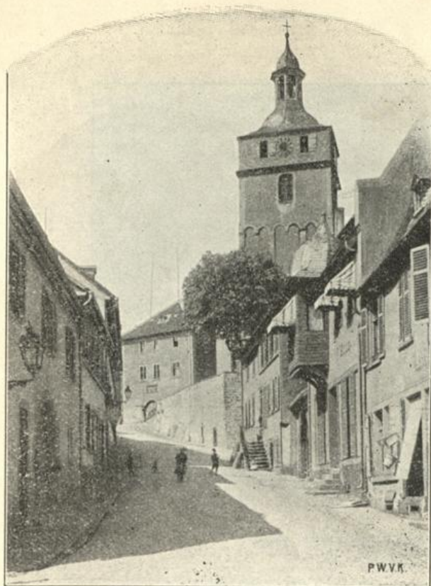
Oelberg, Turm der Peterskirche.
