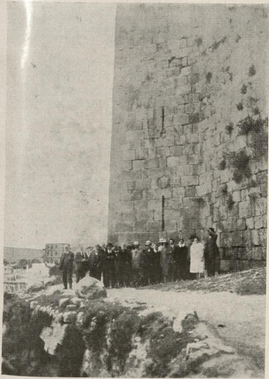
Östliche Stadtmauer von Jerusalem oberhalb der verschwundenen Davidsstadt.
