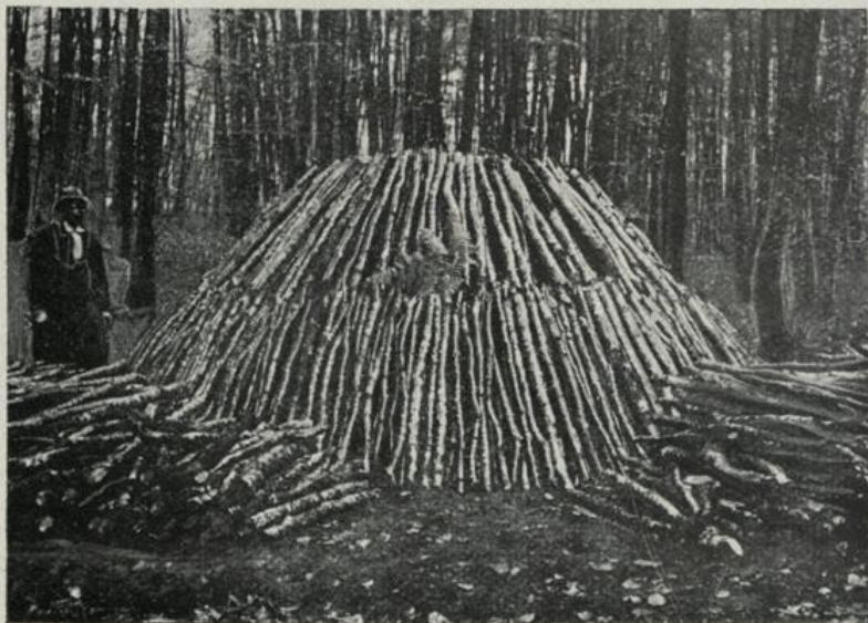
Meiler im Rohbau
