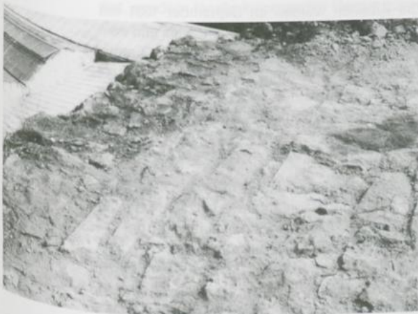
Eulenturm, Plattform über dem oberen Kuppelgewölbe
