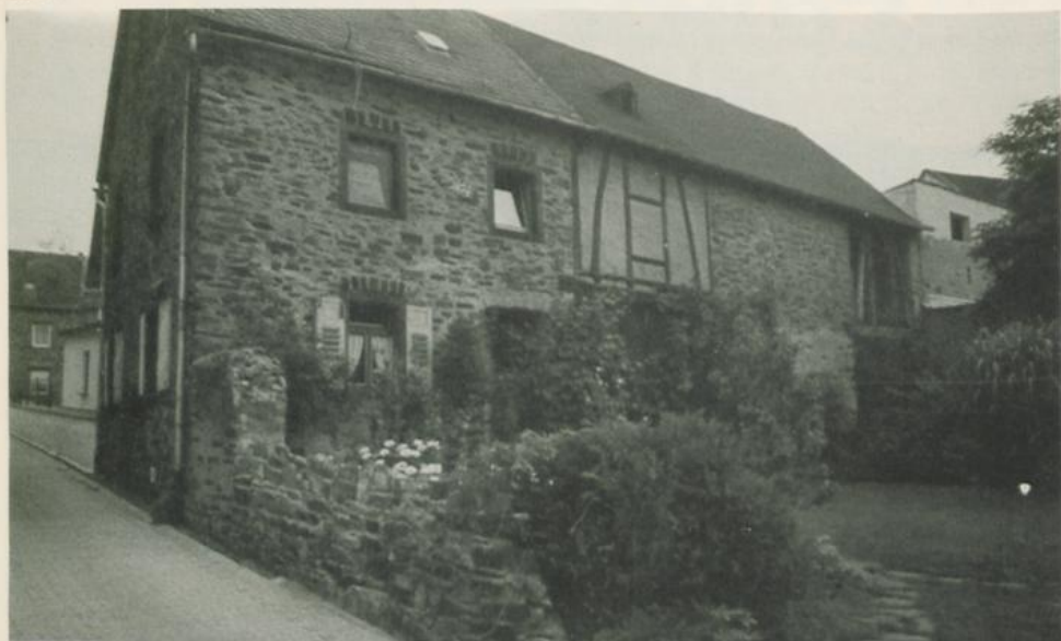
Beispiel eines renovierten Bruchsteinhauses in Moselsürsch.
