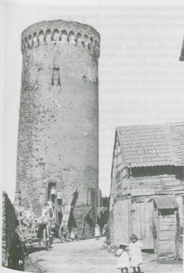
„Pulverturm“ vor der Renovierung
