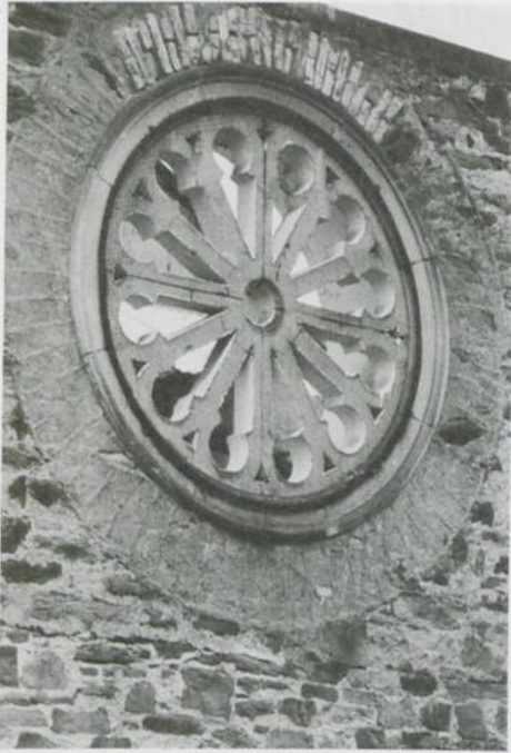
Die noch vorhandene Rosette in der Rückwand der ehemaligen Synagoge
