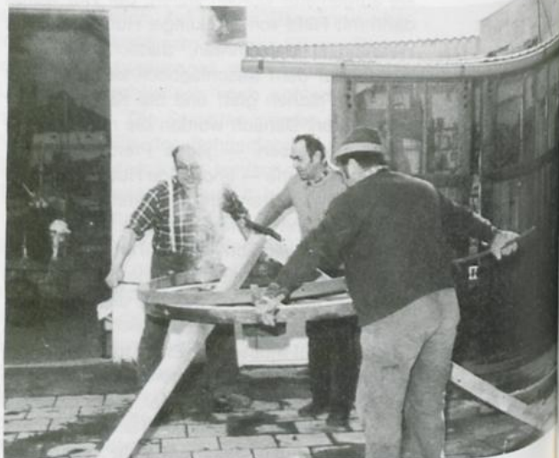
Mitte: Warmmachen eines Wagenreifens in der Feuerschüssel
