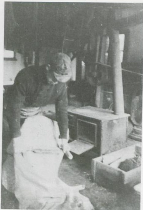
Verdünnen und Egalisieren des Leders mit einem Falzmesser bei der Herstellung von Oberleder
