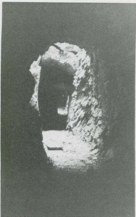
Antike römische Felsenstollenleitung bei Brey. Der Lichteinfall in dem Stollen kommt aus den antiken Arbeitsschächten
