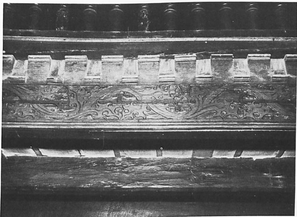
Abb. 90 Oberdiebach, Balkenverkleidung mit Zinnen und Ranken in Zweitverwendung unter der Empore
