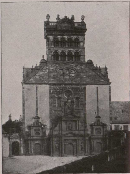
Abb. 17. St. Matthias-Basilika. Westfassade.
